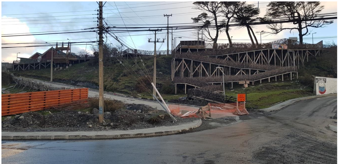
Figura N° 20: Fotografía Rampa de acceso de la Costanera
