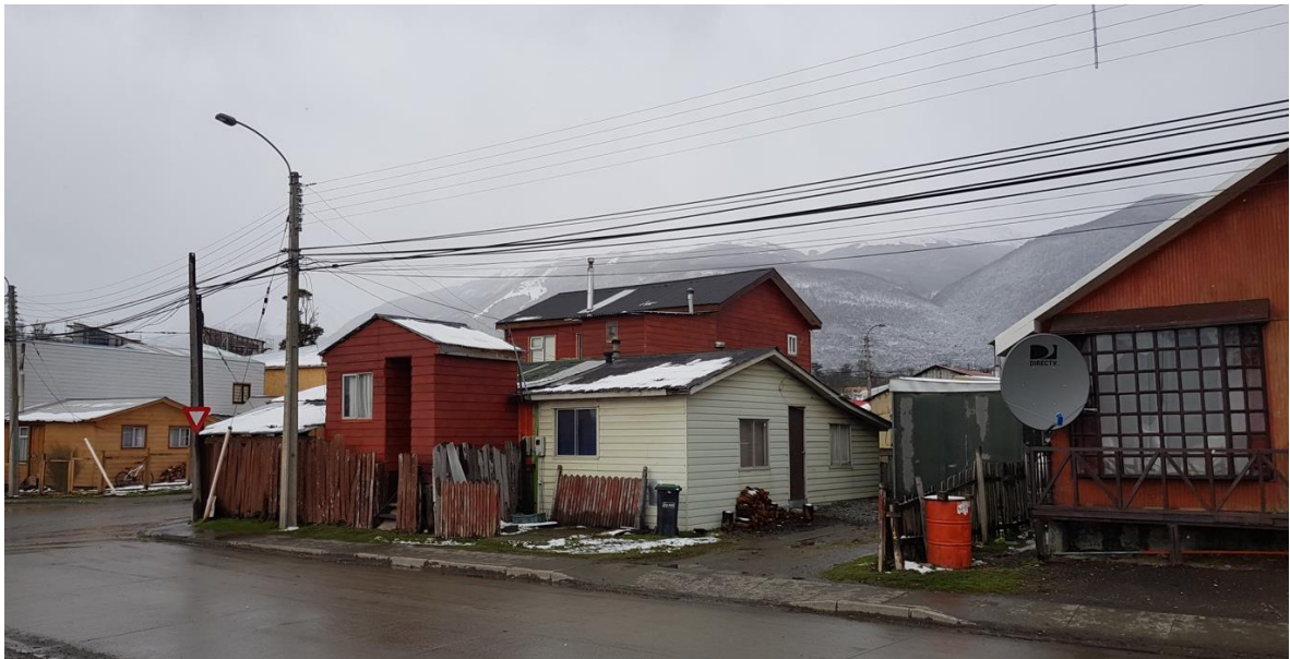
Figura N° 22: Fotografía de las Viviendas
