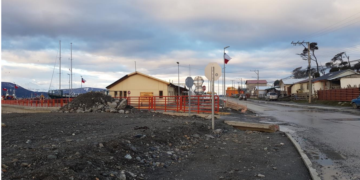
Figura N° 19: Fotografía de la Costanera
